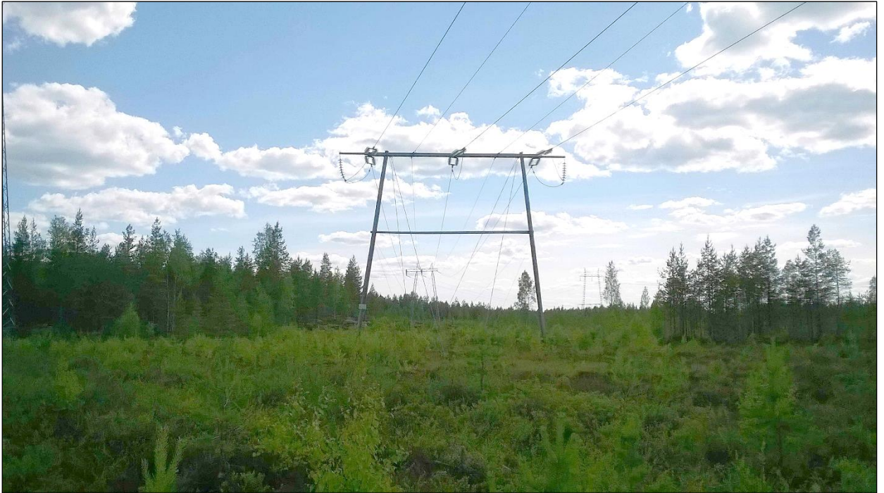
Kuva otettu alueen kaakkoisosasta, koordinaattipisteestä N 6992035 E 356981, pohjoiseen. Kuvassa olevan linjan oikealle (itä) puolelle on suunniteltu rakennettavaksi uusi voimajohtolinja.
